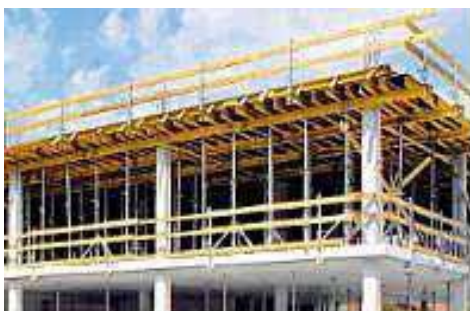
Födém teljes betonlemezzel
