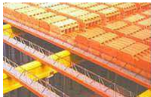
Födém előregyártott gerendákkal
